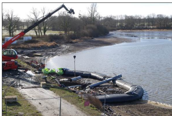
Travaux hydrauliques devant la chaussée de l'étang (photo : J. MOULINAT/CD23)
