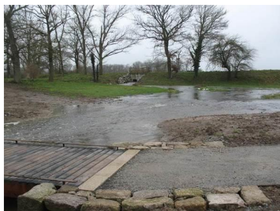
Une nouvelle passerelle pour intégrer le nouveau fonctionnement hydraulique lié au second déversoir de crue (S. BUR / CD 23)
