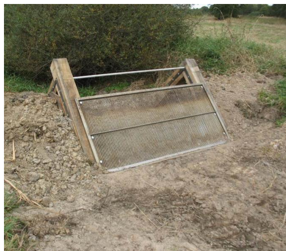
Mise en place des grilles amont barrant le ruisseau de l'Ermitte à sec durant l'été (S. BUR/CD 23)
