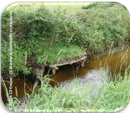
Création de sous berge
