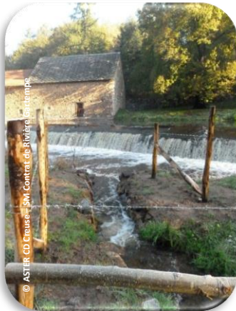
Canal de contournement de seuil
